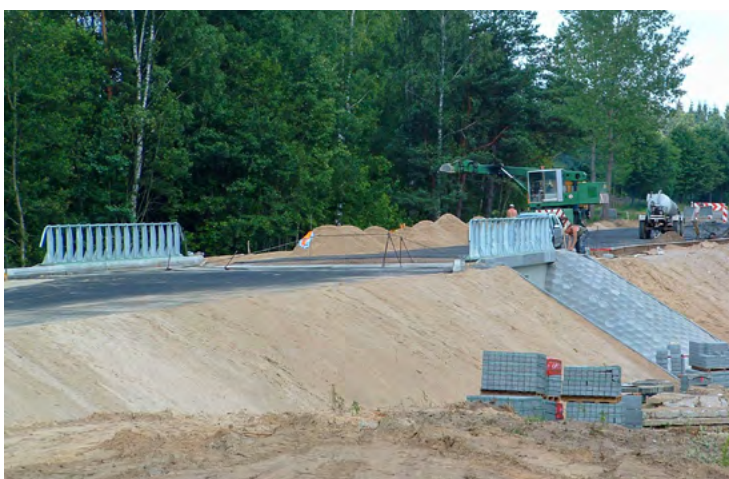
Modernizacja Drogi Krajowej nr 16 – kluczowego szlaku komunikacyjnego w województwie warmińsko-mazurskim.
