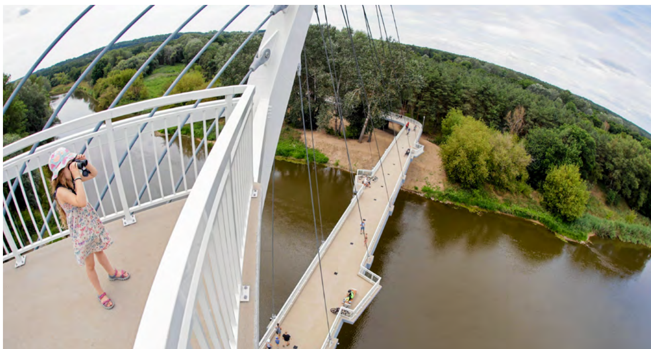
Kładka pieszko-rowerowa nad Wartą, zbudowana ze wsparciem środków unijnych, 19 lipca 2023.
